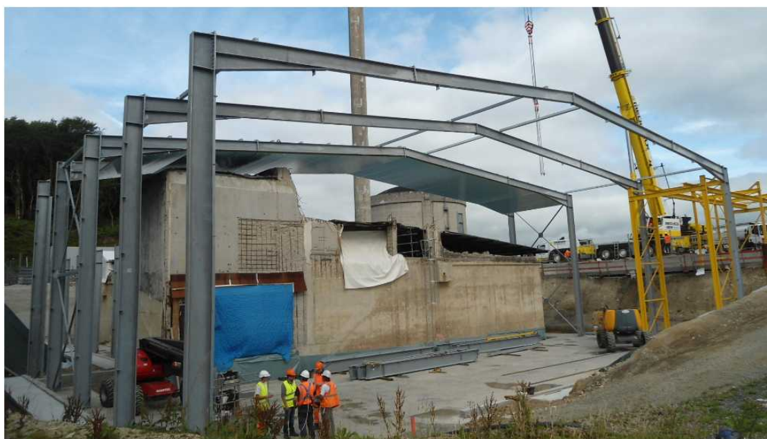
Figure 2 : Photo de la STE avec les talus et la mise en place du confinement
